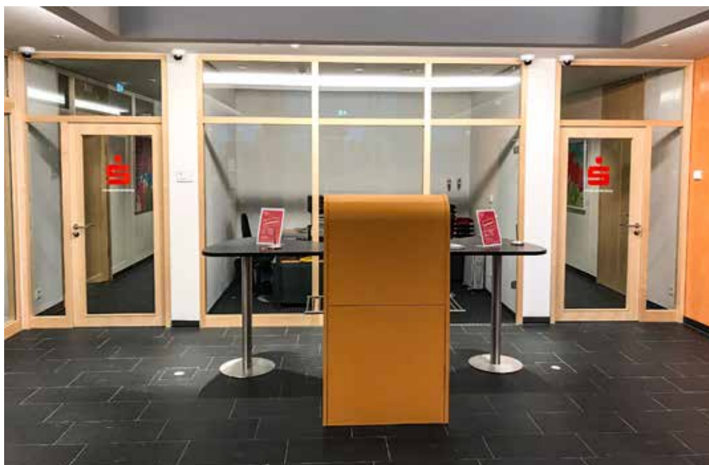
KÖ-PRBILD-TM0004 Türelement Links und rechts: Glaswand mit F30-Brandschutzverglasung Türelement mittig: Glaswand mit Ganzglastür
